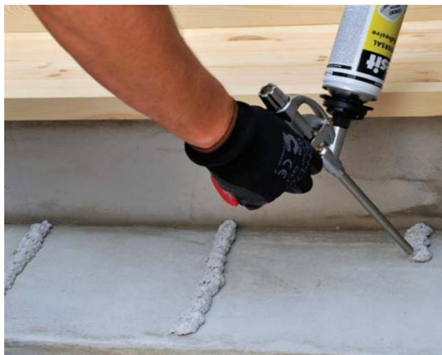
Kāpņu montāža, izmantojot putas.
