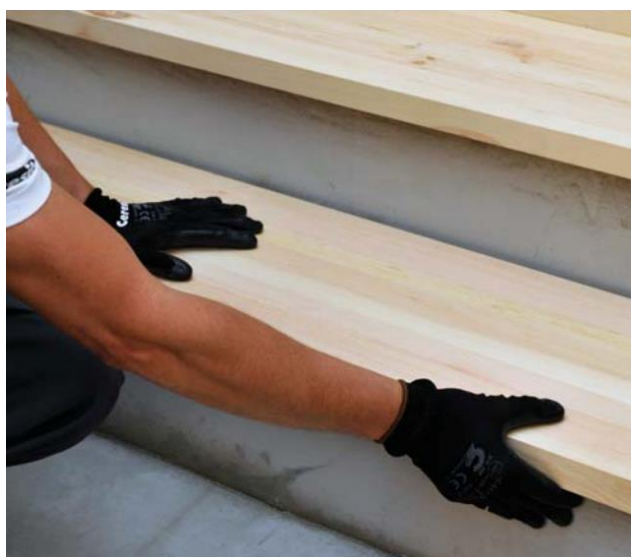
Pakāpienu uzstādīšana un tā stabilizēšana.
