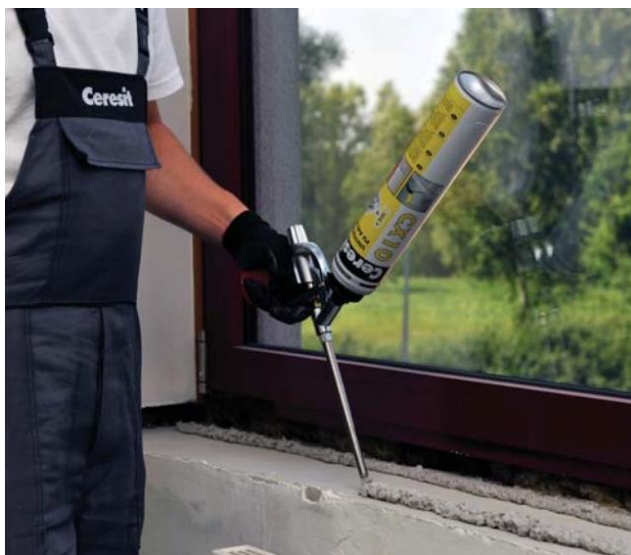
Palodzes montāža ar putu palīdzību
